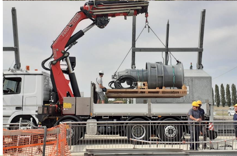
Installazione nuove pompe Il Conte Sala Bolognese
