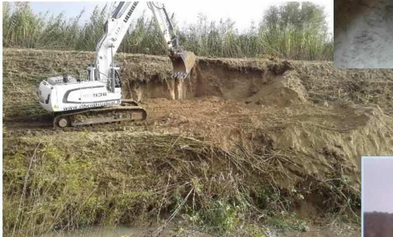
Ricostruzione arginatura danneggiata da animali fossori – t. Lavino loc. Prati
