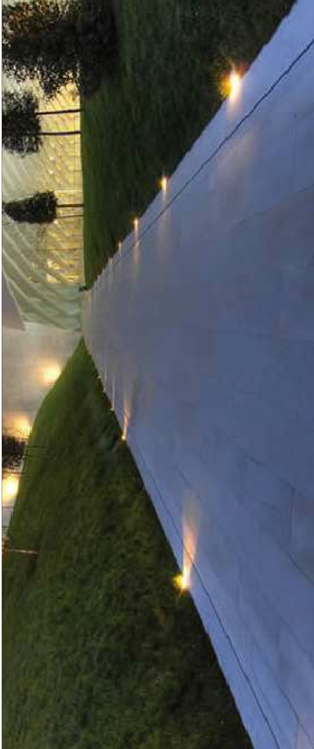
DETTAGLIO D6: Proiettore a terra (segnapasso)
